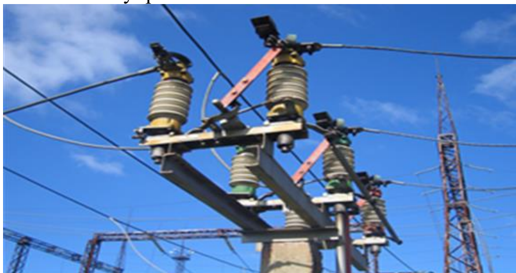
Рис. 8. Разъединитель наружной установки РЛНД-35
