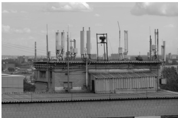
Рис. 3.9. Пример размещения антенн базовой станции сотовой связи на крыше здания
