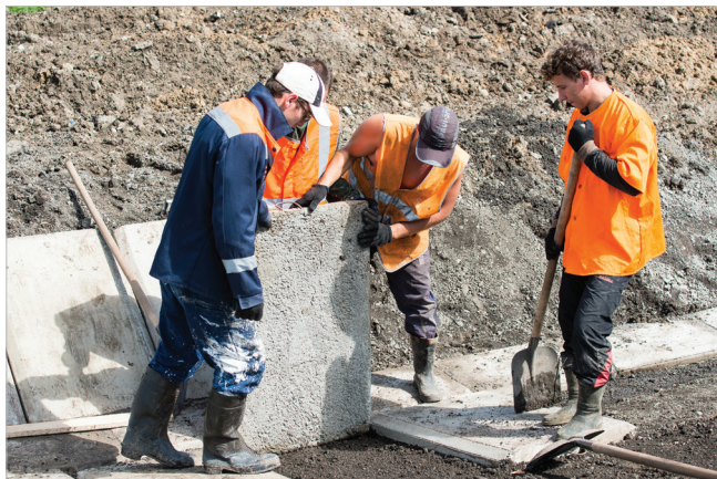
Бойцы укладывают бетонные плиты для дренажной системы трассы.
