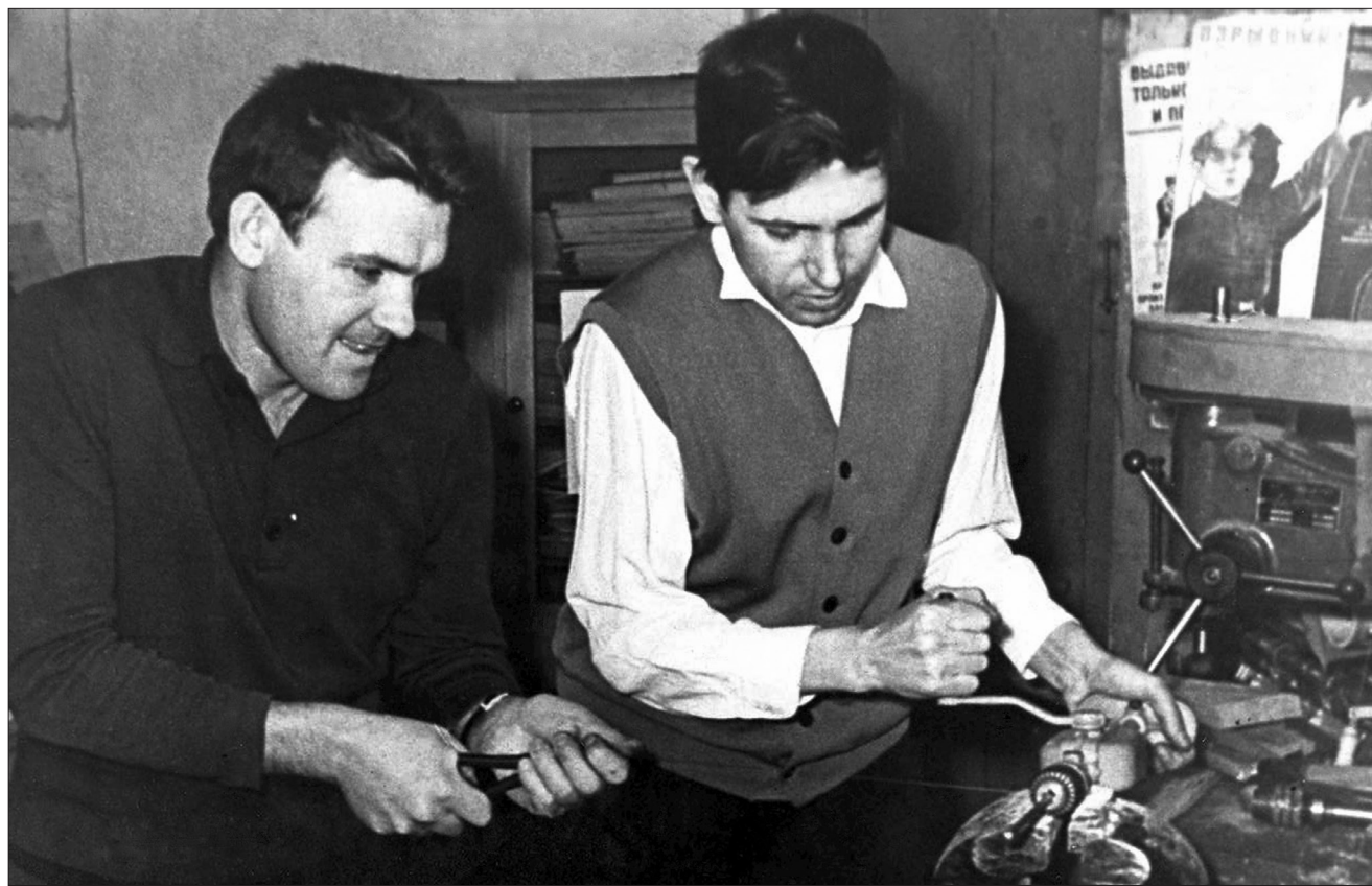
Студенты группы ГР-662 В. Иванов и В. Меркулов изготавливают оптико-механический прибор, с помощью которого студенты и преподаватели кафедры разработки рудных месторождений будут обследовать состояние взрывных скважин. 1968 год.
