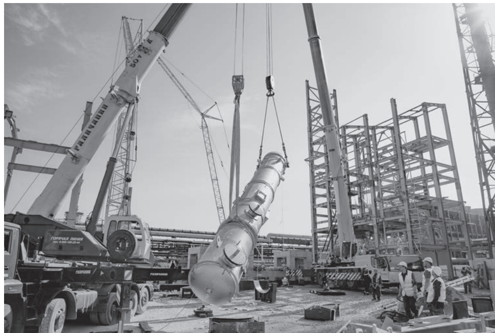
Монтаж лицензионного оборудования на строящейся установке по производству неконцентрированной азотной кислоты на промышленной площадке цеха № 15 КАО «Азот»
