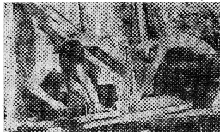
— НА СНИМКЕ: студенты Г. Угрюмов и В. Алесик делают опалубку для бункера автоматической подачи угля в вагоны.
